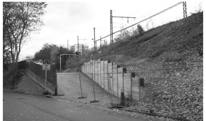
Sortie du chantier (novembre 2022)
