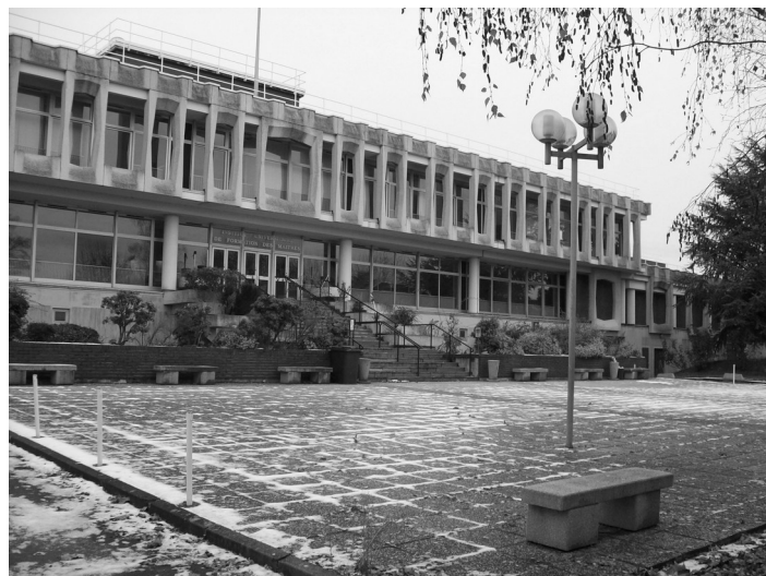
Pour mémoire, le bâtiment principal de l'IUFM (à l'emplacement de la Résidence Harmony)
